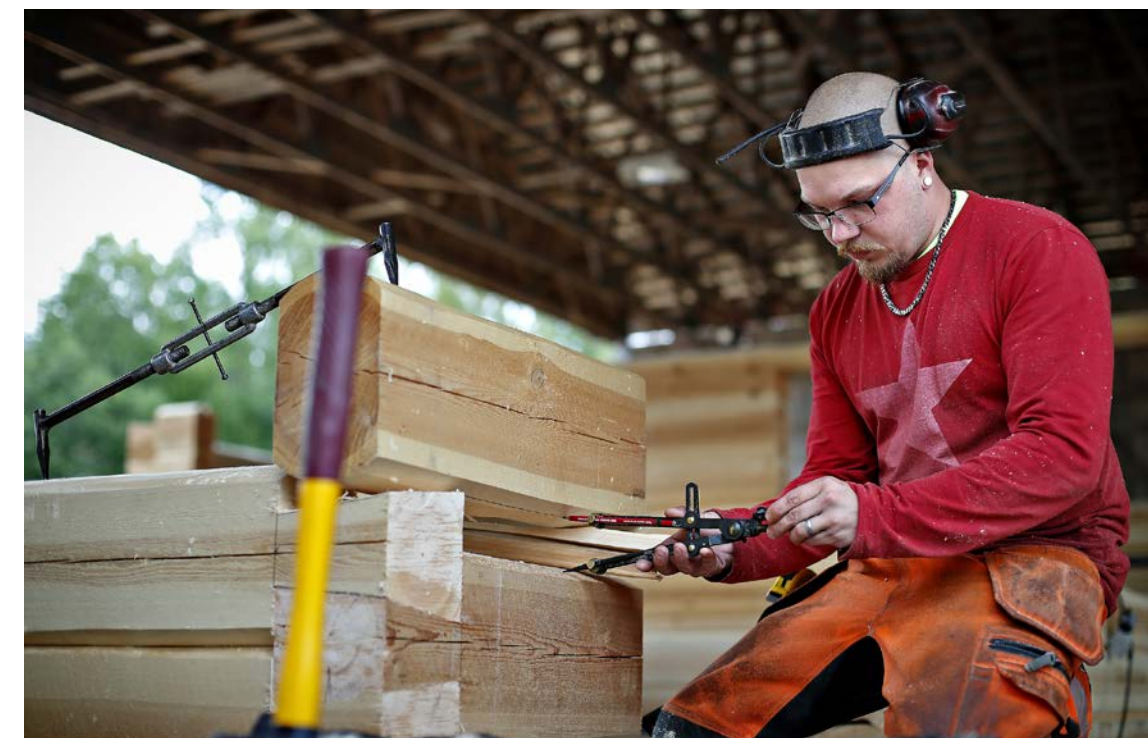
Iso harppi on käsinveistossa tärkeä työkalu. Sillä kopioidaan alemman hirren muodot tarkasti ylempään hirteeseen. Niko Mäkipelto näyttää, miten se tapahtuu.
